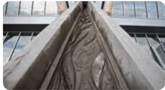
Regenwasser-Sammelsystem Über diese Fische rinnt das Regenwasser, das für die Toilettenspülungen verwendet wird. Fische waren – und sind es in einem gewissen Sinne immer noch – eine der Hauptnahrungsquellen der Völker der Nordwestküste Kanadas.
