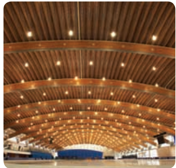
Dach des Richmond Olympic Oval aus Recyclingholz.
